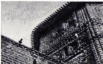
Поробрик (указан стрелкой) в кладке юго-западной башни и примыкающей к ней стены (всё — 17 в.) Горицкого монастыря в Переславле-Залесском.
